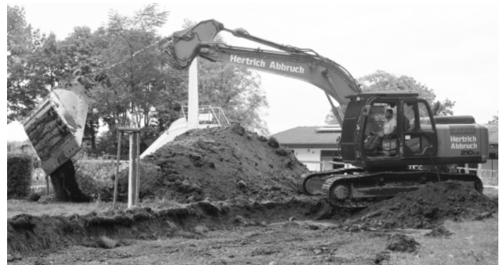
Ein Teil der Liegewiese des Auenheimer Freibads wird in den kommenden Monaten zu einer sogenannten Baustraße umfunktioniert.
